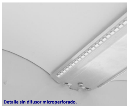
Detalle sin difusor microperforado.
