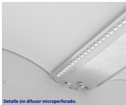
Detalle sin difusor microperforado.
